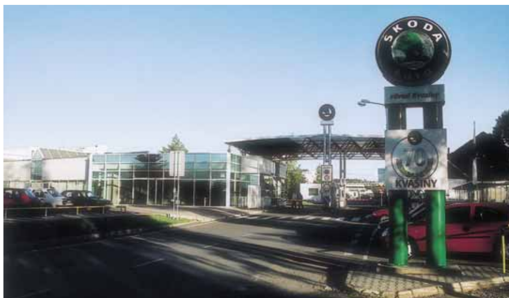
OBR. 6 ZA BRANAMI REKONSTRUOVANÉ TOVÁRNY V KVASINÁCH SE RODÍ SOUČASNÁ CHLOUBA AUTOMOBILKY
