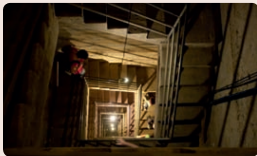
Schodišťová šachta do podzemí tvrze Skutina
