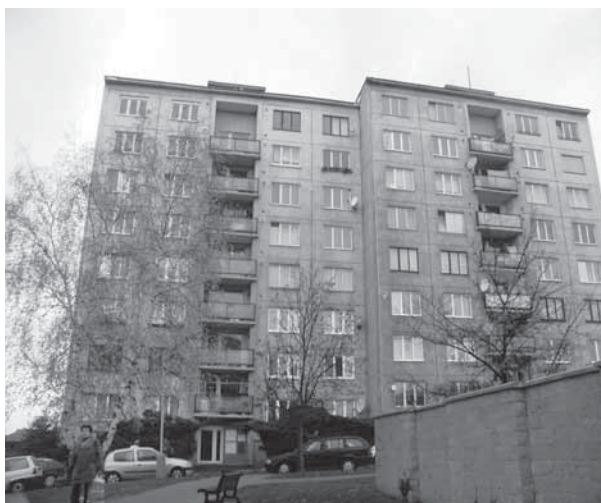
Obr. 4.4 Karlovarská varianta soustavy T 06 B
