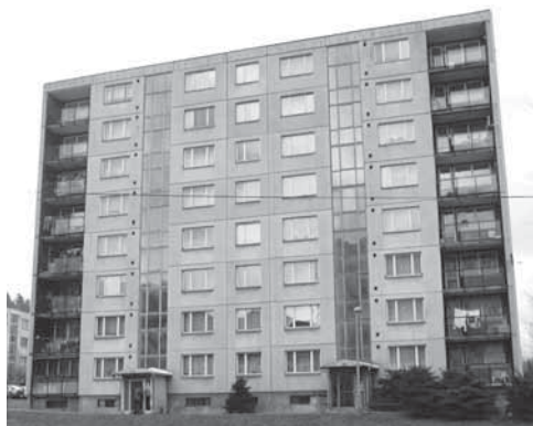
Obr. 4.6 Příklad fasády domu panelové soustavy BA-NKS
