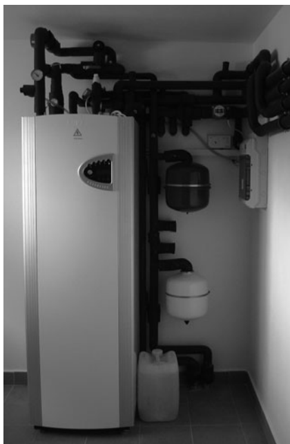
Obr. 2 Tepelné čerpadlo země/voda
