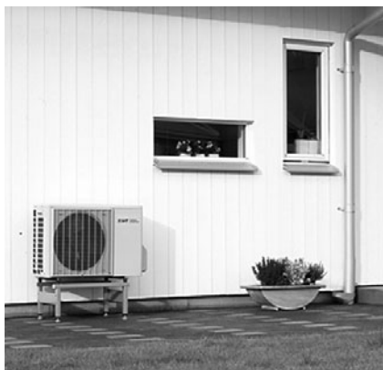
Obr. 5 Tepelné čerpadlo vzduch/vzduch – venkovní jednotka
