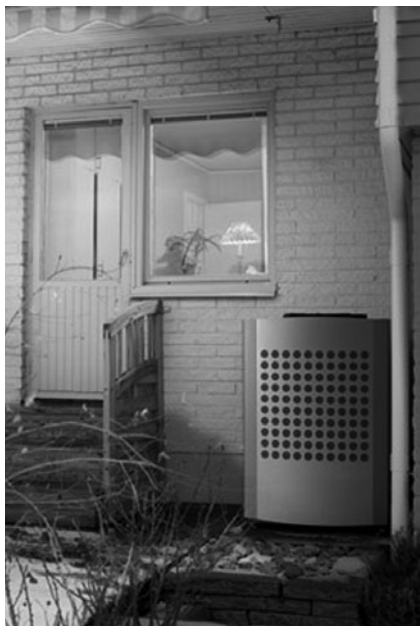
Obr. 3 Tepelné čerpadlo vzduch/voda – venkovní jednotka
