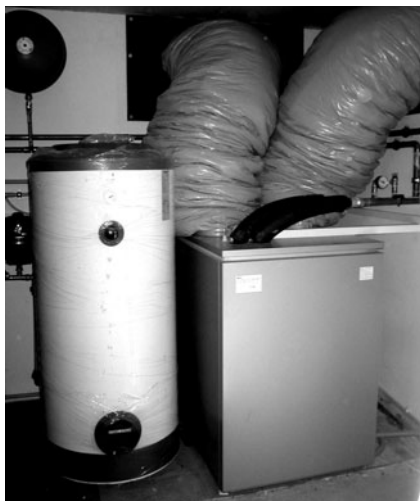
Obr. 4 Tepelné čerpadlo vzduch/voda – vnitřní provedení
