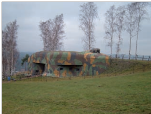
Běloves – srub Březinka
