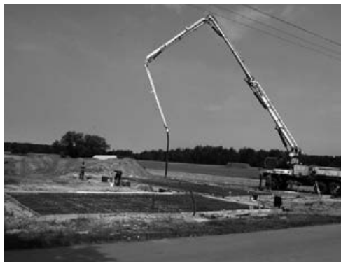
Obrázek 1 Lití betonu na připravenou výztuž základové desky (zdroj: Základy rodinného domu)
