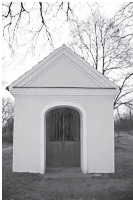
Kaple sv. Víta na místě „dlouhého domu“
